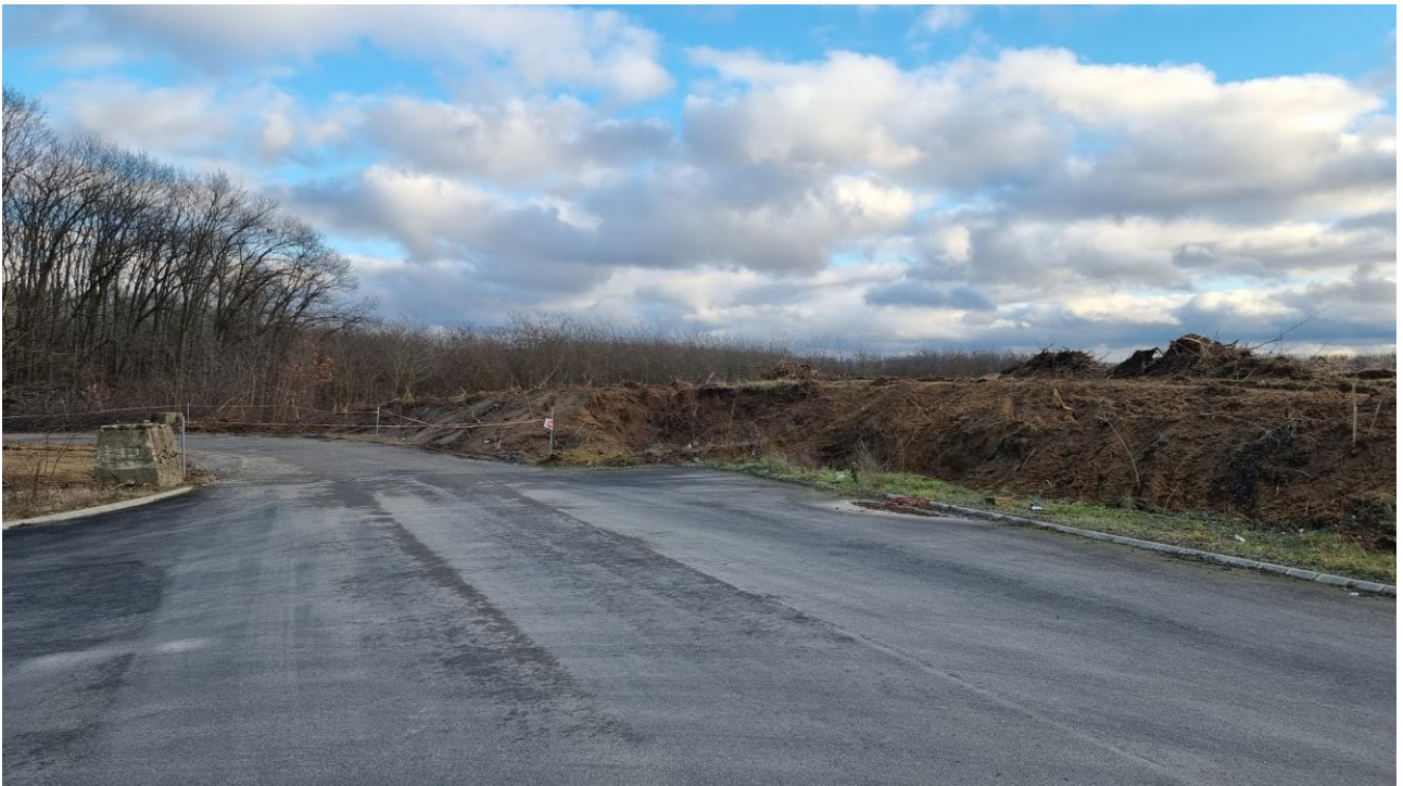
077hrs-ú t elfordulása 111 számú vasútvonalnál. Forrás: Saját fotó
